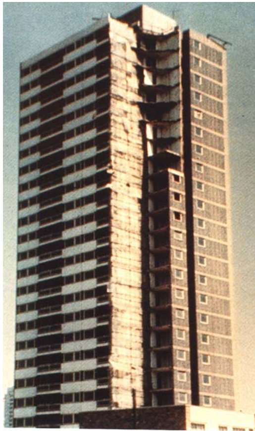
Slika 1 - Progresivni kolaps dijela solitera Ronan Point u Londonu /2/
